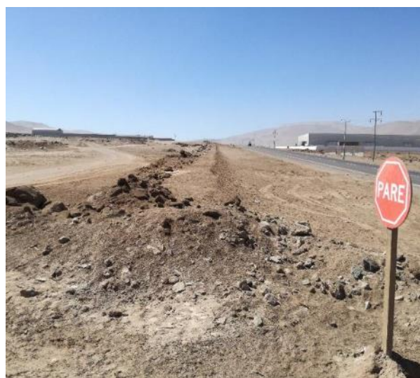
Fotografía N° 4 – 31/08/2018: Paso de acceso provisorio sobre aducción de agua.
