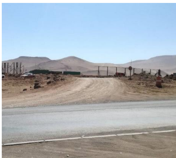
Fotografía N° 3 – 31/08/2018: Paso de acceso provisorio sobre aducción de agua.
