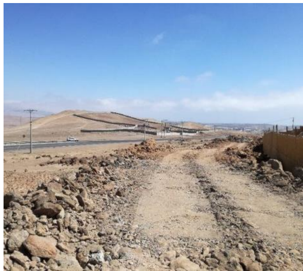
Fotografía N° 5 – 31/08/2018: Escombros en faja fiscal de la Ruta A-616.
